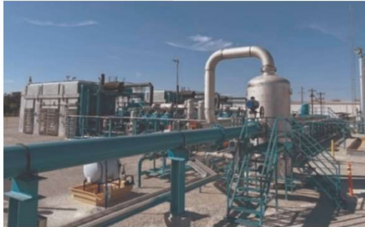
รูปที่ 4.6 คอมเพรสเซอร์สำหรับอัดเพิ่มความดันในท่อขนส่ง CO 2 ของโครงการกักเก็บคาร์บอนของเครือบริษัท BKV Corporation ณ เมืองแคลลิส รัฐเทกซัส สหรัฐอเมริกา
