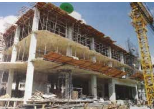
อาคารวิจัยโยธีขณะก่อสร้าง
