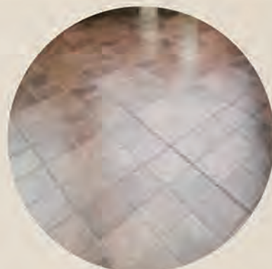
พื้นที่กระจายแรงได้ไม่ดี ไม่ลดแรงกระแทก เดินได้มั่นคง วัสดุแข็ง
